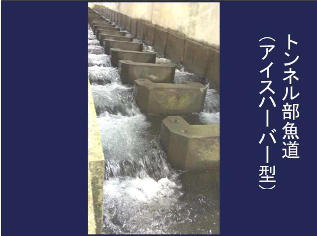
実際の動画で水の流れを見てください。魚が休むように中央にC型ブロックを置いて流れに淀み(よどみ)をつけるように設計しているけど、魚にとってはかなりの体力が必要です。
