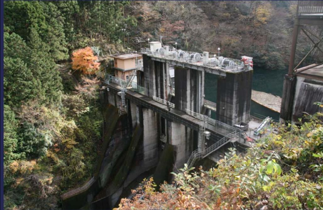
白丸ダムは、1963年に東京都交通局が管理する発電用ダムとして完成しました。建設費用は32億円。形式は、重力式コンクリートダムで、高さは30m、堤頂長は61mですが、小河内(おごうち)ダムに比べると小さなダムです。
