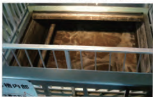
8月 昭島の下水処理場を見学
